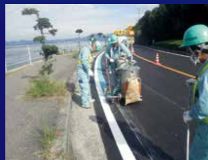
しまなみ海道サイクリングロードの区画線工事
